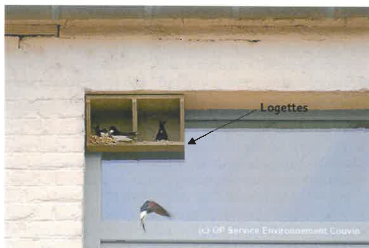
Figure 3 : Schémas d'aménagement en faveur des hirondelles à réaliser sur les bâtiments existants
