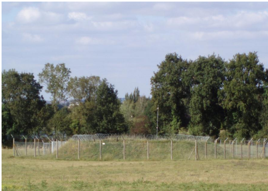
Photo du dépôt A d'une capacité de 16 t. On remarque le merlon de protection.
