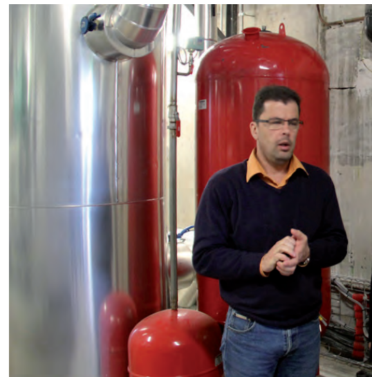
Sous-commission de sécurité à la piscine ARAGO à sous-préfet, directeur de Cabinet en présence du chef de service prévention SDIS 85 et du gestionnaire d'exp
