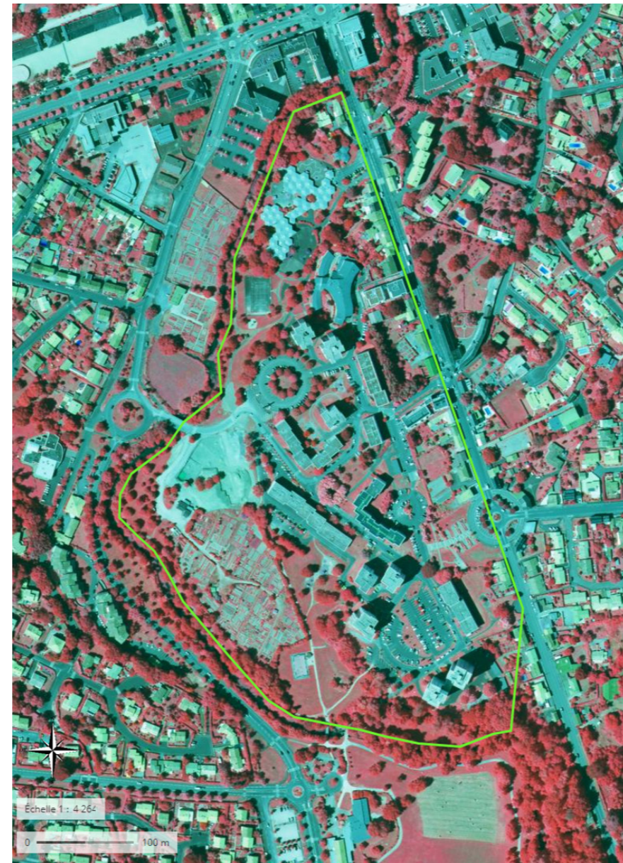
Figure 56 : Photo aérienne infrarouge du site du projet - source Geoportail
