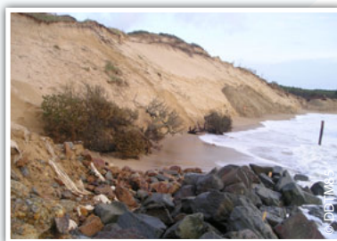
Erosion du trait de côte malgré le système d'enrochement
