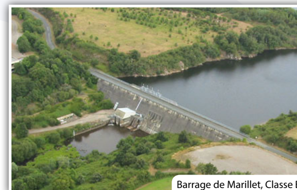
Barrage de Marillet, Classe B
