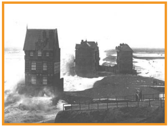
Franchissements par paquets de mer
