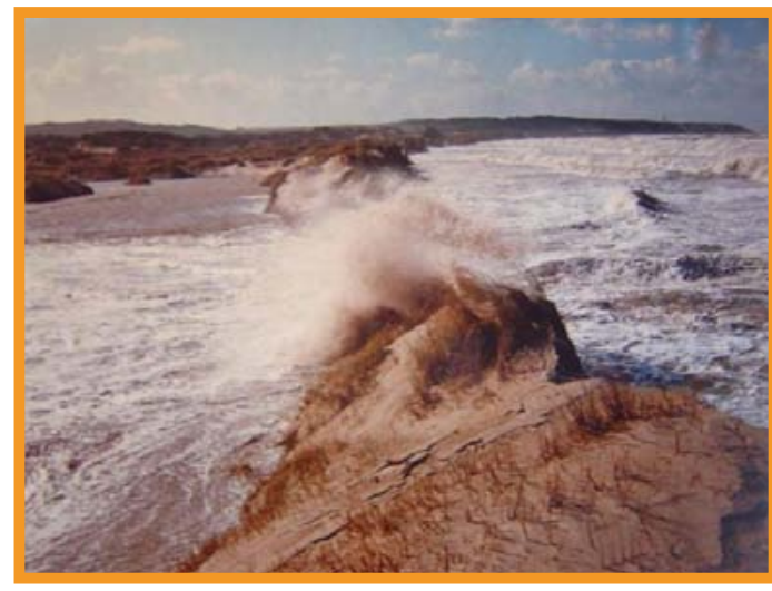
Risque lié à la défaillance du système de protection contre les inondations
