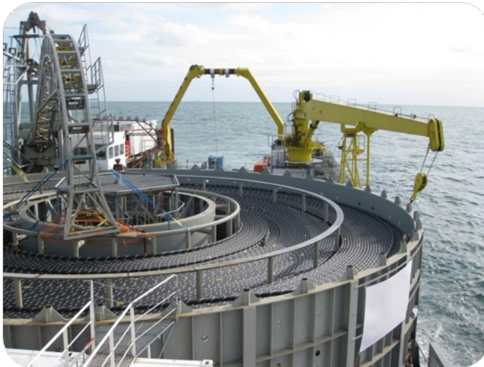
Câble enroulé sur le bateau
