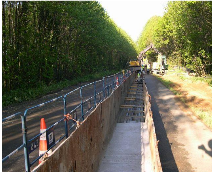
Pose en ½ chaussée
