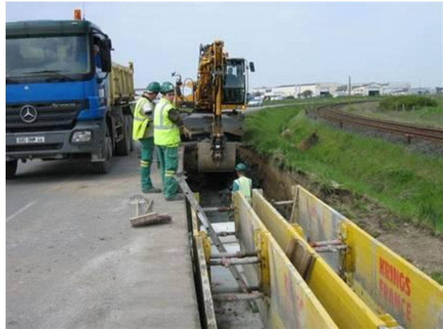
Pose en accotement
