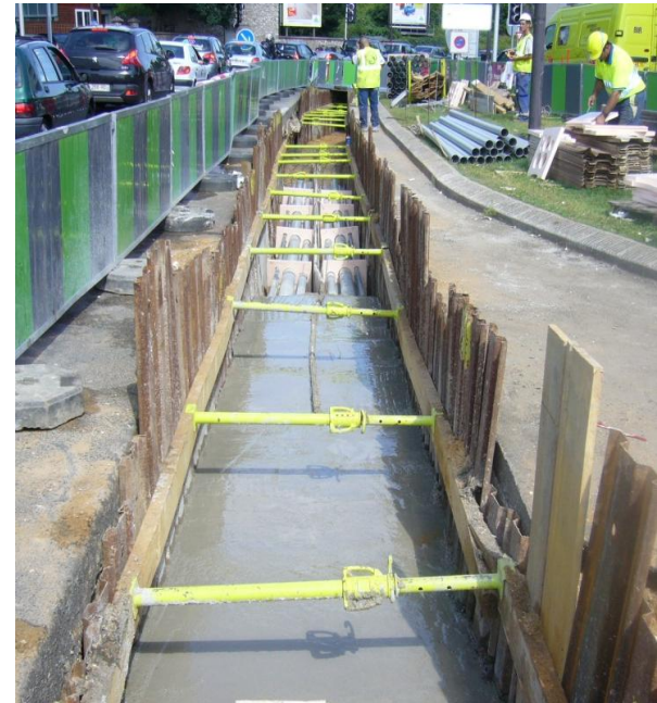
Tranchée et béton sous chaussée
