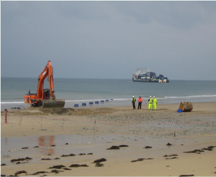
Tirage du câble sur l'estran depuis une barge
