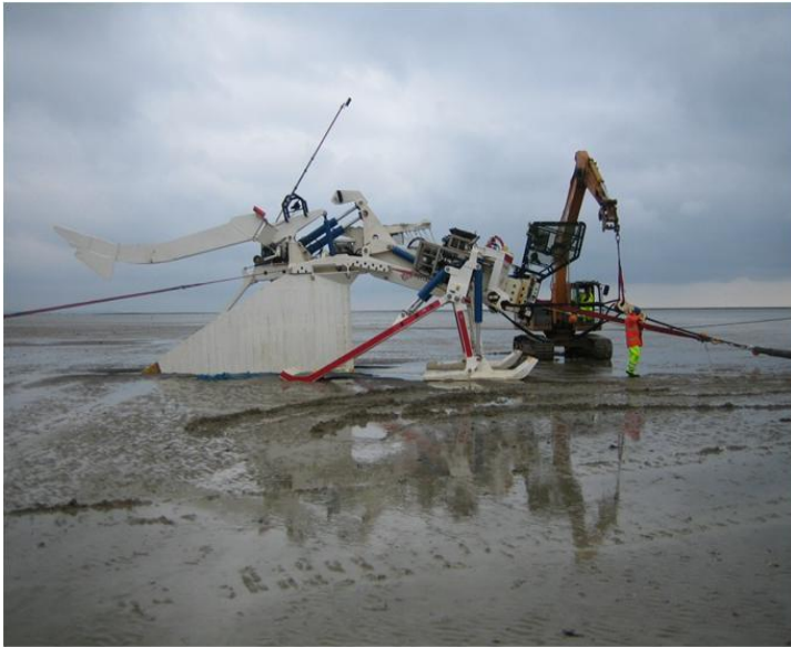
Travaux sur estran avec pose du câble par charriage
