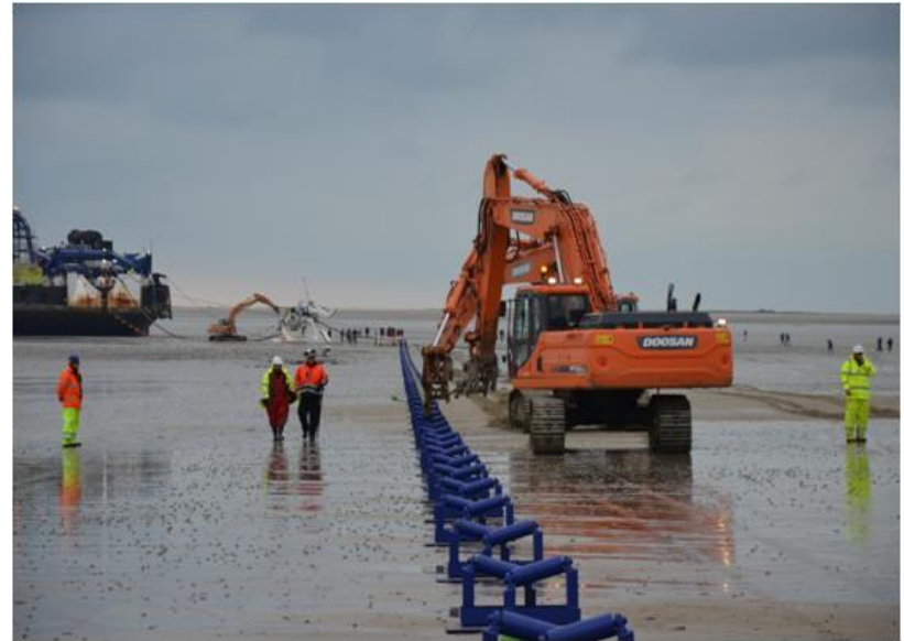
Pelleteuse sur estran pour pose du câble
