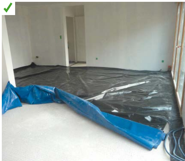
2. Pose du reste de la membrane une fois l'enveloppe terminée. ©Marvaud
