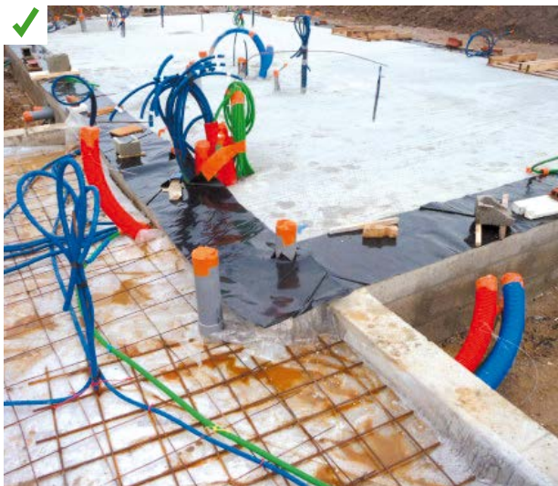
1. Pose de la membrane sous les murs. ©Marvaud
