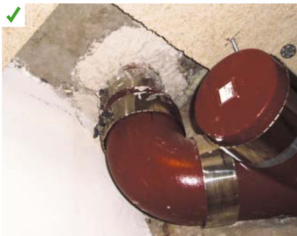
Obturation de défauts d'étanchéité. ©CTSB
