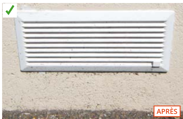
Agrandissement des ouvertures d'un vide sanitaire.
