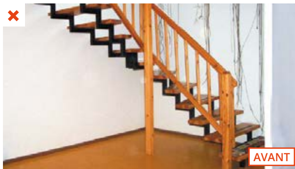
2. Étanchement de l'escalier menant à la cave par la création d'un sas. ©OFSP
